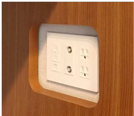
マルチメディアコンセント開口
