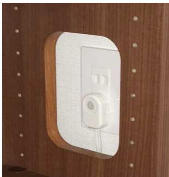
コンセント開口
