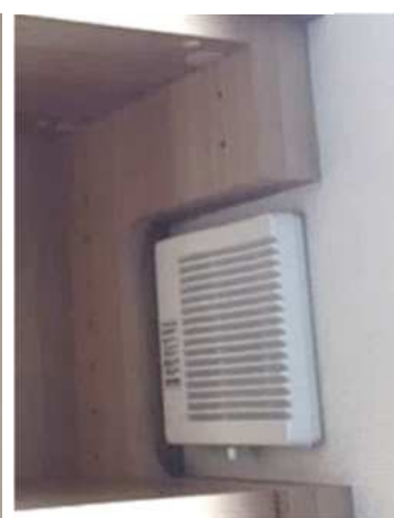
換気孔コ欠き開口
